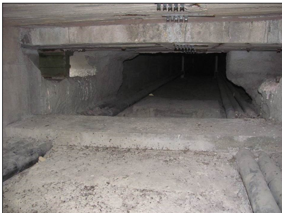
Obr. 5: Detail zmonolitněného kloubu v poli 2 [1]
