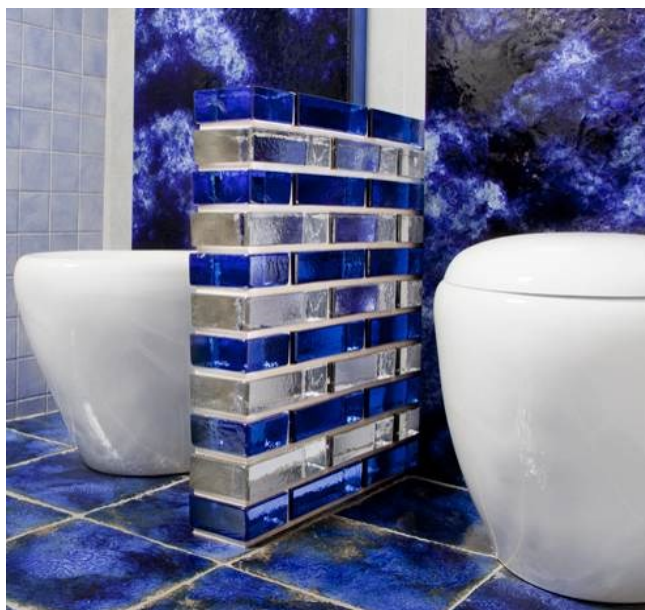
Obr. 4 Dělicí příčka z cihel VetroPieno [6]
